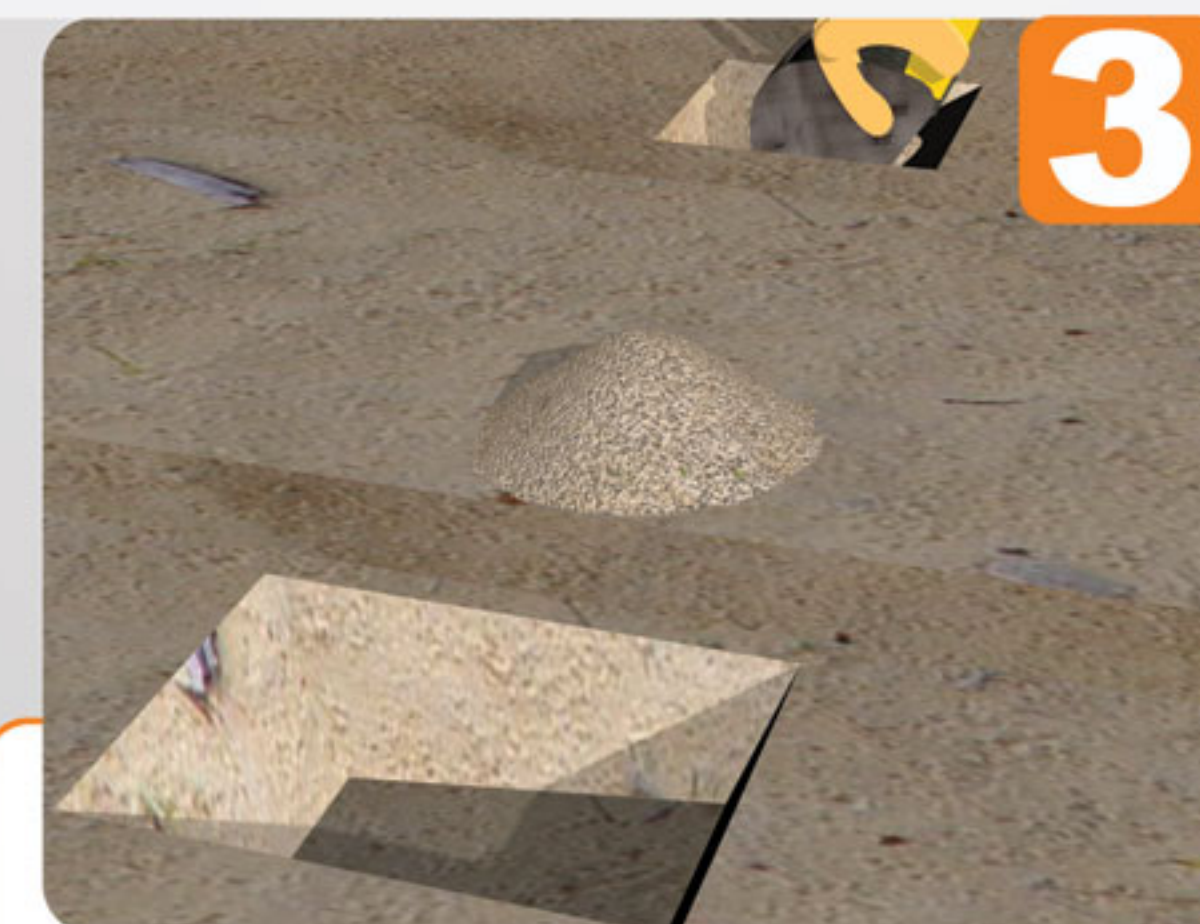
عملية الحفر حسب أبعاد الأساس و حتى منسوب أسفل بيتون النظافة
